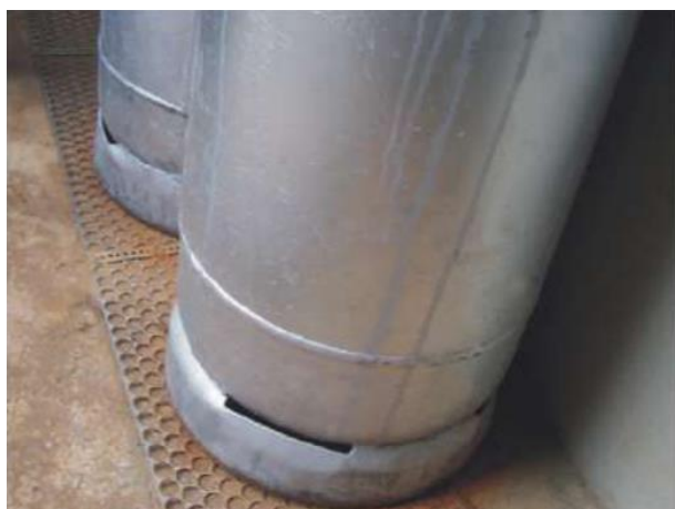
Figura 8 - A tela em inox é utilizada para a equipotencialização de botijões em centrais de gás.
